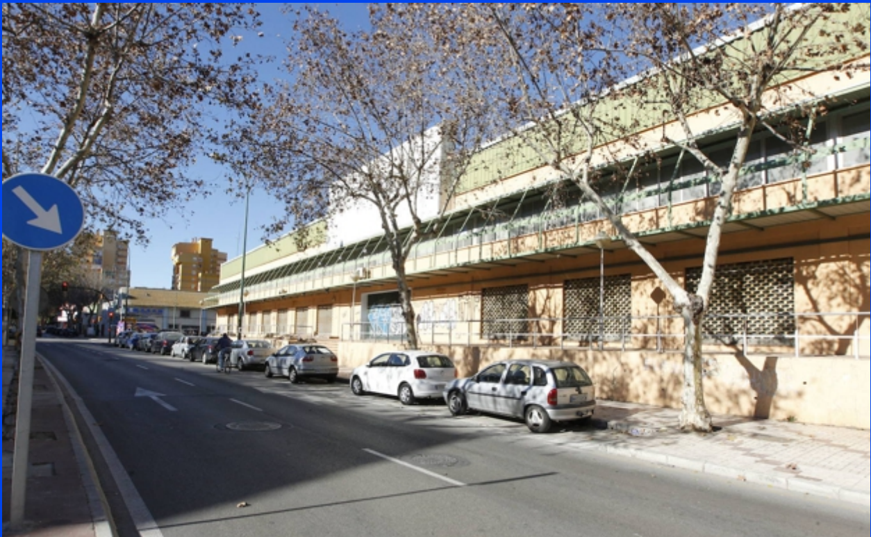
Naves de la calle Balazón para las que el Ayuntamiento planea su transformación en un centro comercial. / SUR
